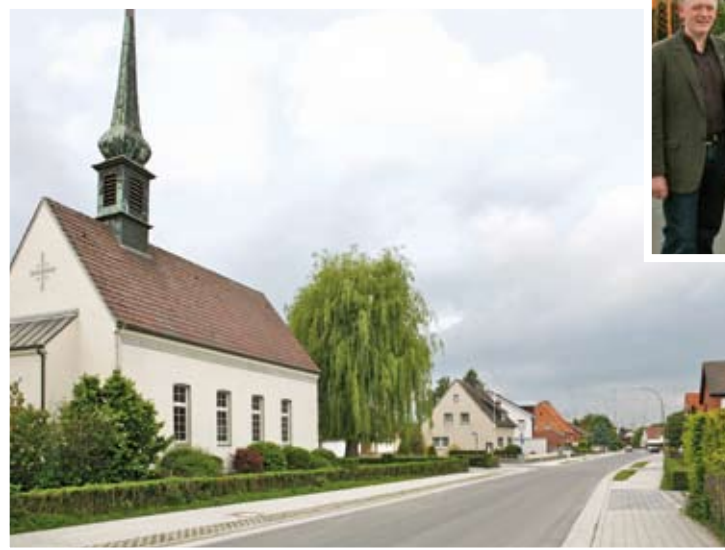
Straßenerneuerung Schluitskamp in Störmede
